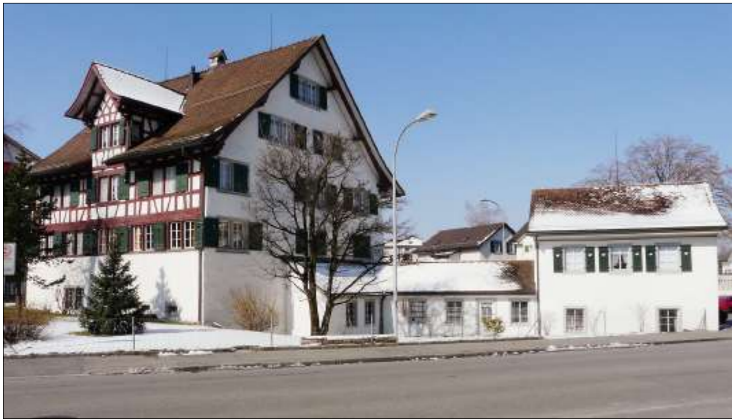
«Farb» in Wetzikon mit dem angebauten kleinen Blaufärbereigebäude (Kulturdetektive).
