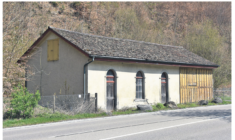
Erste Turnhalle und ehemalige Gasfabrik in Unter-Aathal. (Kulturdetektive 2019)
