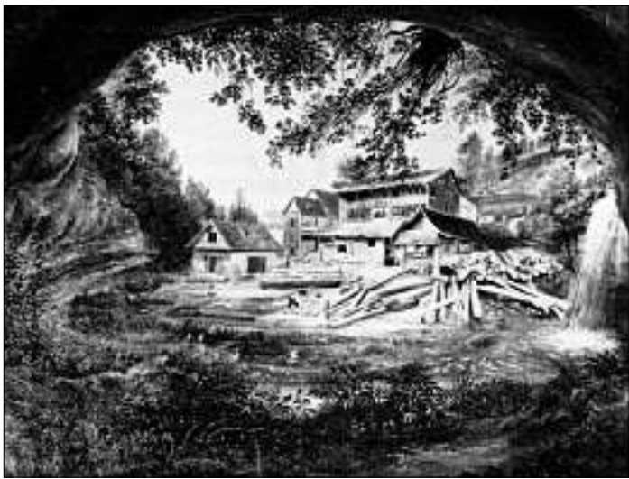
Mühle Weisslingen: Der Bohlenständerbau mit waagrecht ausgefachten Zwischenteilen und einem Fensterband mit Fallläden neben einem Wasserfall ist auf dem Ölgemälde von Johann Ulrich Buri (1. Drittel 19. Jahrhundert) gut ersichtlich («Kunstdenkmäler des Kantons Zürich», Bd. 3, S. 220).
