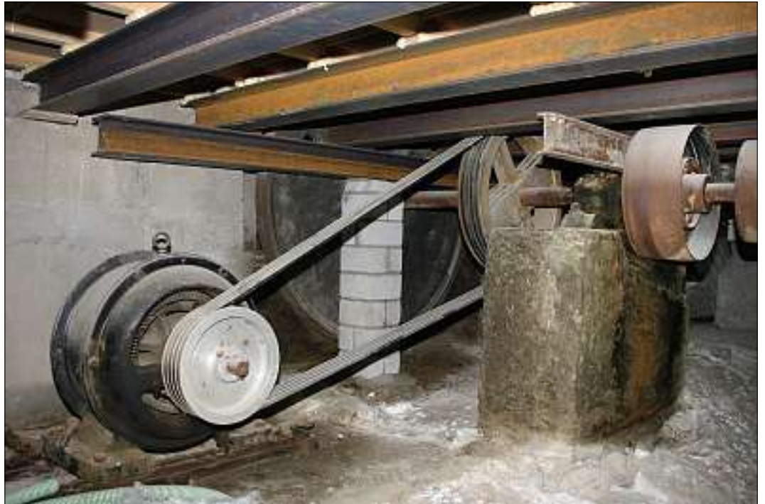
Mühle Kempton/Wetzikon: Welle zur Kraftübertragung mit Transmissionsriemen (Foto: Kulturdetektive).
