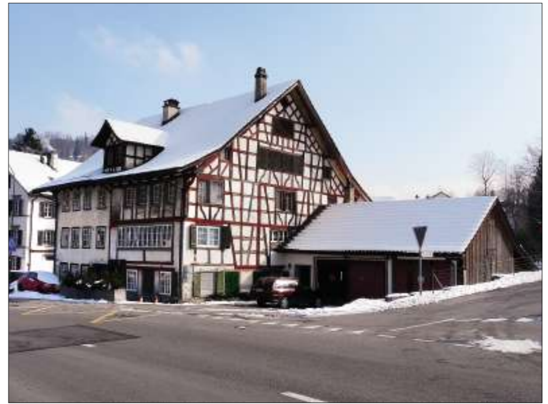
Haus «Zur Farb» in Bauma mit dem eingeschossigen Blaufärbereigebäude (Kulturdetektive).
