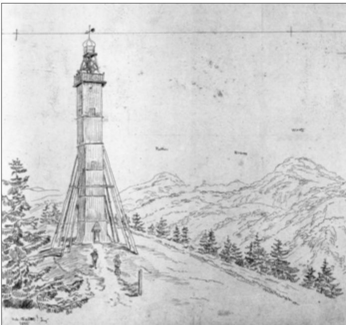
Hölzerner Bachtelturm von 1873. (Ortsarchiv Hinwil)
