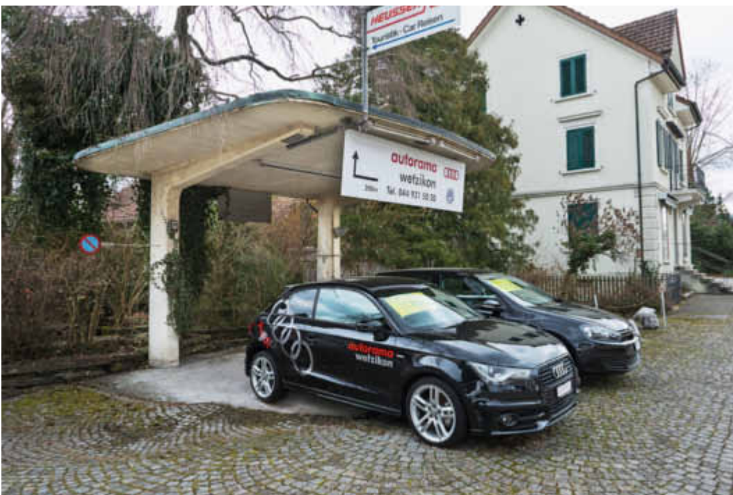
Ehemalige Tankstelle an der Usterstrasse in Wetzikon. (Renato Bagattini)
