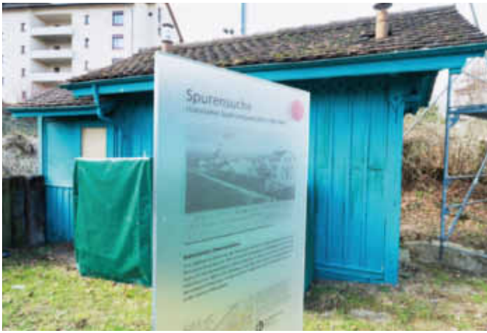
Bahnwärterhäuschen beim ehemaligen Bahnhof Oberwetzikon von 1876. (Renato Bagattini)
