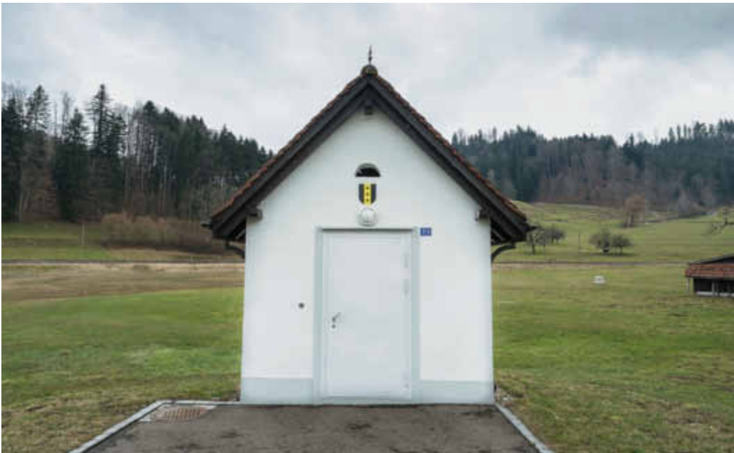
Pumpwerk Bussenthal von 1943. (Renato Bagattini)
