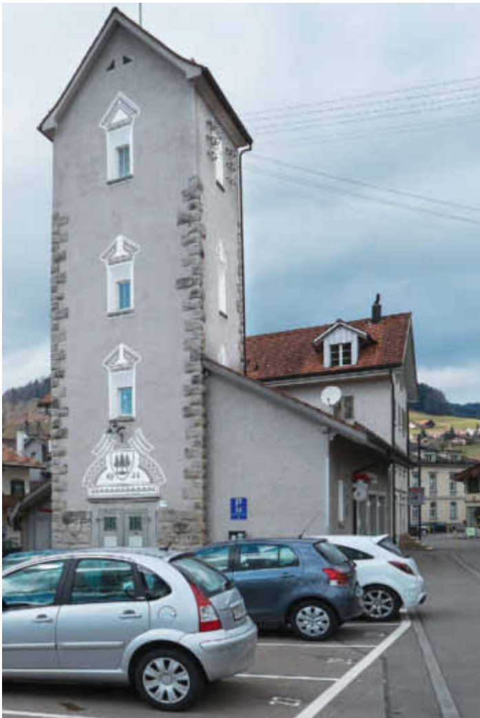
Transformatorenturm Wald mit Sgraffito von 1924 und den Abspanndrähnen rechts oben im Bild. (Renato Bagattini)
