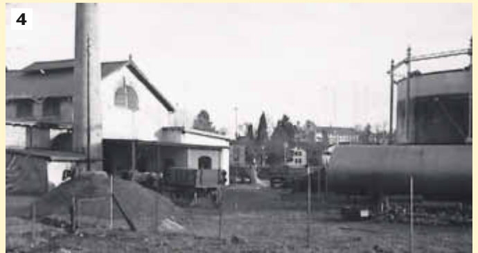
1937: Das Gaswerkareal kurz vor dem Bau des neuen Kohlemagazins. Das Baugerüst steht bereits. Links steht die Gasfabrik mit dem Werkstattanbau und rechts der Gasometer mit dem 1931 installierten Hochdruckspeicher (Archiv Geschichte Wetzikon).
