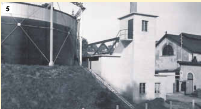
Dezember 1937: Zwischen dem Gasometer und der Gasfabrik entstand ein 500 Tonnen fassendes Kohlemagazin mit einem Turm, in welchem ein Förderlift die Kohle hinaufbeförderte auf die Kettentransportanlage (vgl. Plan), welche die Kohle oberirdisch zur Produktionsanlage brachte. Es handelt sich bei diesem Eisenbetonbau um einen typischen Zeugen der Moderne. Auffallend sind die klaren Formen und die filigranen, leicht vorkragenden Betondächer und Vordächer sowie die luftige Betonausstentreppe in den Getrieberaum (Archiv Geschichte Wetzikon).
