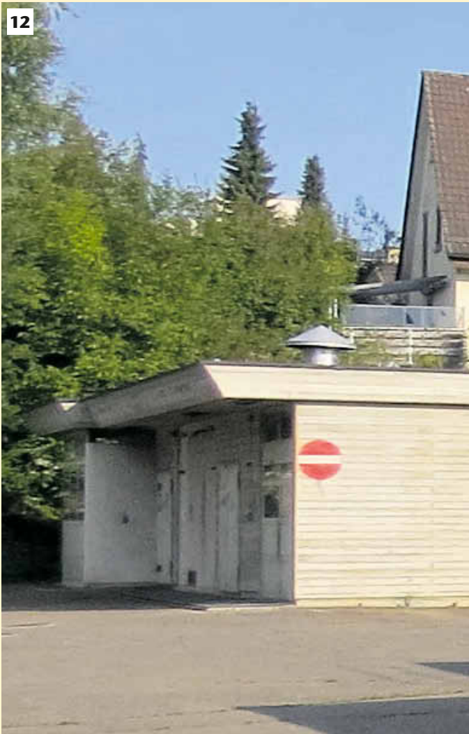
Heutige Situation mit dem modernen Verteilzentrum (Foto Kulturdetektive 2013).
