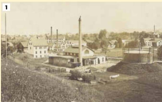
In der Mitte des Areals, direkt an der Bahnlinie, steht das Gaswerk mit dem Hochkamin, dahinter angebaut das Werkstattgebäude mit dem Kohlekeller. Rechts daneben präsentiert sich auf diesem Foto von 1908 der markante Gasometer. Am linken Bildrand sieht man das Wohn- und Verwaltungsgebäude an der Bertschikerstrasse. Zum Wohnhaus gehörte der Pflanzgarten im Vordergrund (Archiv Geschichte Wetzikon).
