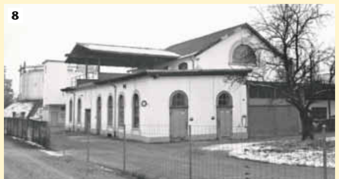
1972: Blick von der Bahn auf die Gasfabrik. Sehr schön sieht man hier über der Werkstatt die Schwefelreinigungsanlage, die 1952/53 eingerichtet wurde. Der ursprünglich offene Satteldachaufsatz ist heute durch ein festes Dach ersetzt (Archiv Geschichte Wetzikon).
