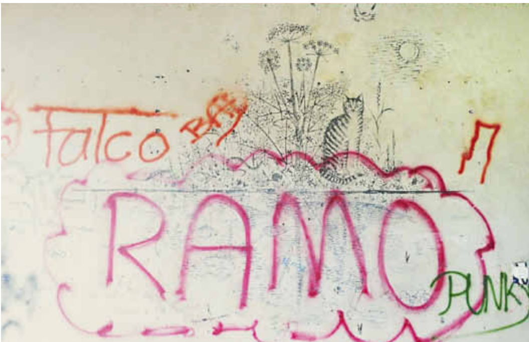
Schülermalereien auf der Holzplatte, die das originale Pitschi abdeckten, 1986. (Foto: Kantonale Denkmalpflege)
