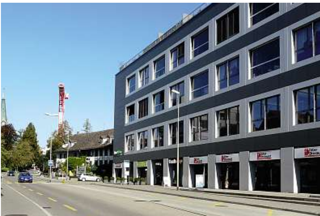
Das ehemalige Kaufhaus Monopol an der Bahnhofstrasse 126 in Wetzikon nach dem Umbau von 2004/05. (Foto Kulturdetektive, 2011)
