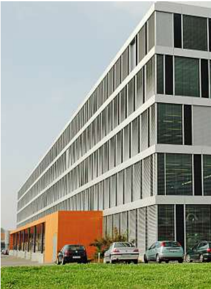
Produktions- und Bürogebäude der Belimo in Hinwil. (Foto Belimo Automations AG, 2000)
