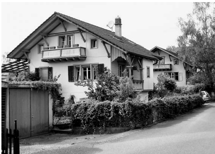
Jakobstrasse, Uster: Teil der Chaletbauten, Gartenstadtsiedlung im Wil. (Bild: Claudia Fischer-Karrer)
