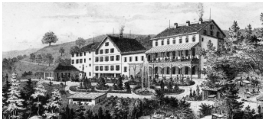
Kurhaus Gyrenbad, Turbenthal (Denkmalpflege Kanton Zürich).
