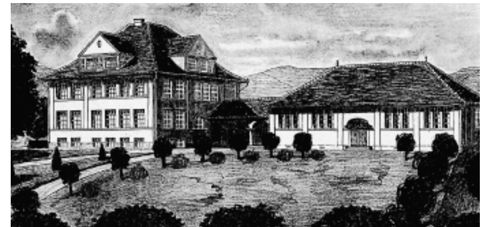
Schulhaus Mätteli, Hinwil (Hochbauamt, Kanton Zürich, Fotoarchiv).
