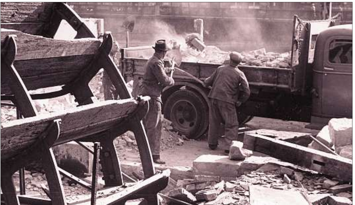
Zürcher Mühlestieg: Abbruch der Wasserräder 1949 (Baugeschichtliches Archiv der Stadt Zürich).
