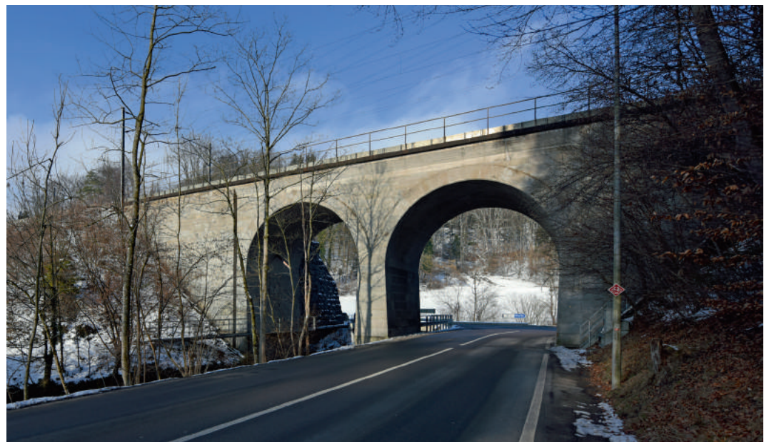
Illnau-Effretikon: Mauerwerksbrücke der Bahnlinie Zürich–Winterthur über die Kempt. (Foto Cornel Doswald)
