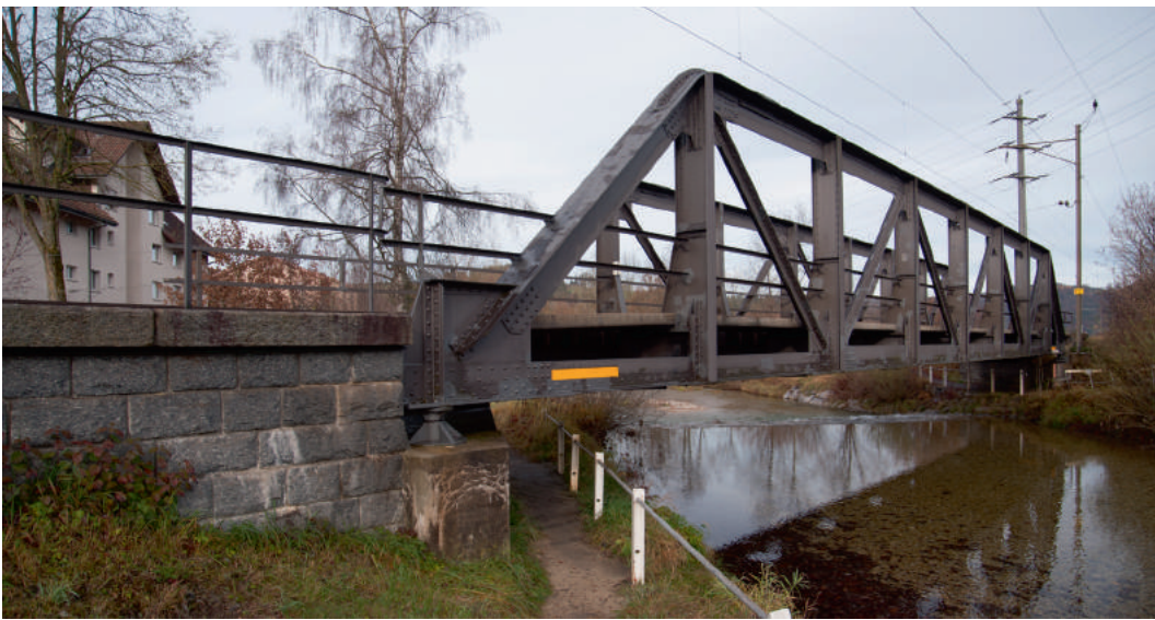
Wila: Stahlfachwerkbrücke der Tössalbahn. (Foto Cornel Doswald)
