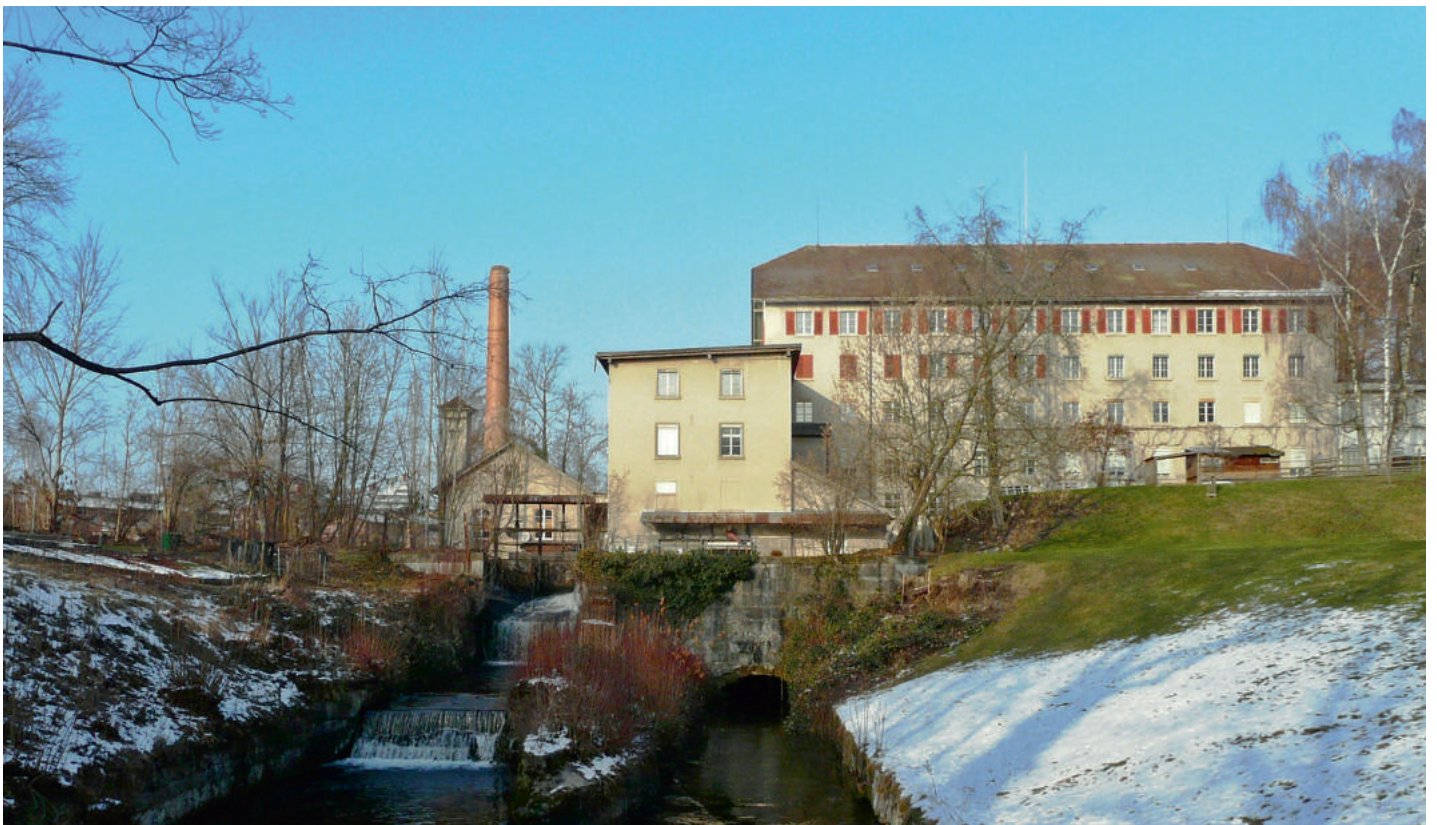
Wetzikon: Ehemalige Spinnerei Schöнау mit Turbinenhaus, Kanalauslauf und Aabach (links). (Foto Jan Fischer, Kulturdetektive)
