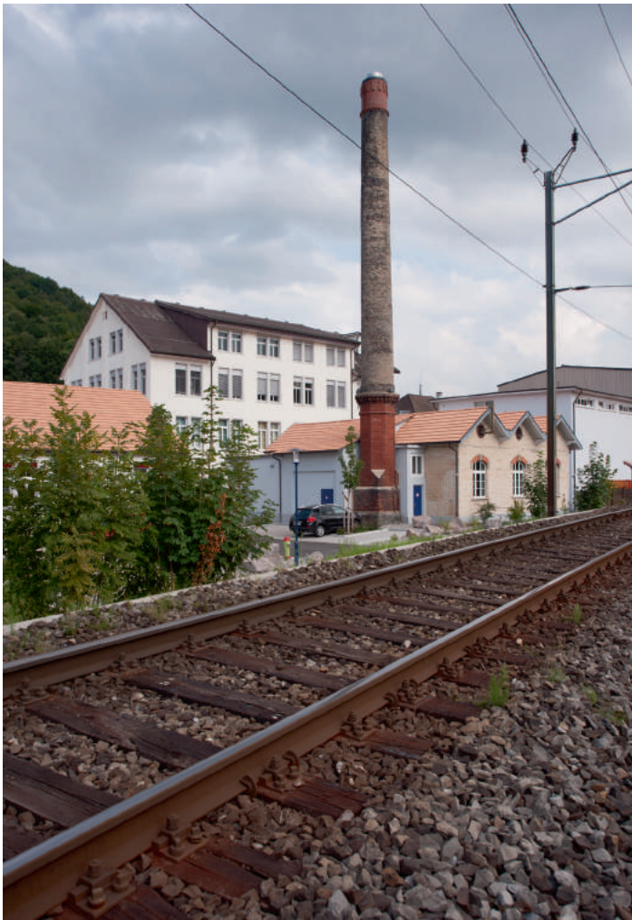
Turbenthal, «Eskimo»: Kesselhaus der ehemaligen Tuchweberei. (Foto Cornel Doswald)
