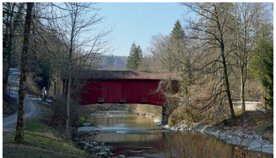
Illnau-Effretikon, Kyburg: gedeckte Holzbrücke über die Töss aus der Zeit des Kunststrassenbaus. (Foto Cornel Doswald)
