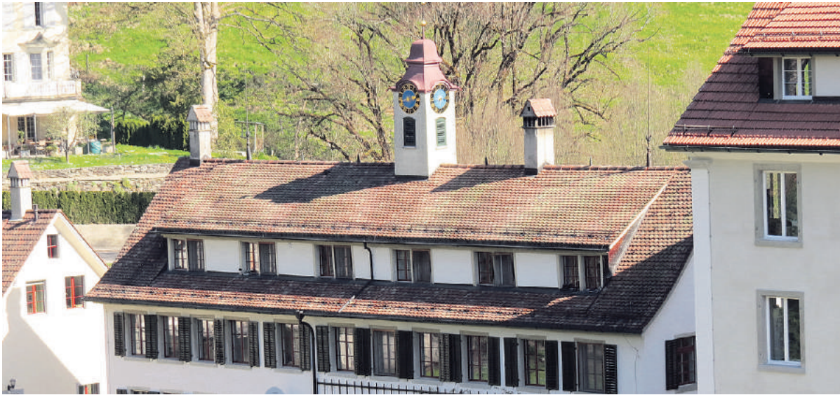
Dachreiter mit Fabrikglocke und Uhr auf dem Fabrikantenwohnhaus Neuthal. (Foto Kulturdetektive 2017)
