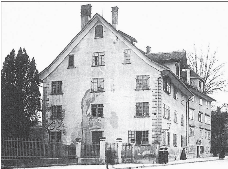
Glockenhaus alt. (Zürcher Denkmalpflege, 1989/1990, S. 52)
