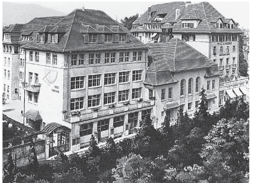
Glockenhaus neu. (Zürcher Denkmalpflege, 1989/1990, S. 57)
