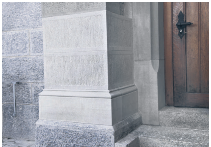
Situation nach der Sanierung. (Beat Meier, 2017)
