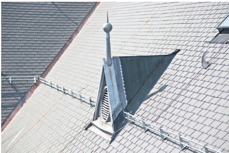
Das erneuerte Dach mit den Aufbauten. (Beat Meier, 2017)
