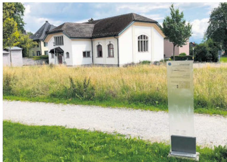
Die erste Turnhalle Wetzikons wurde 1906 gebaut und gehört zu einer Schulanlage mit verschiedenen Gebäuden aus unterschiedlichen Zeiten. Sie wird heute noch genutzt.
